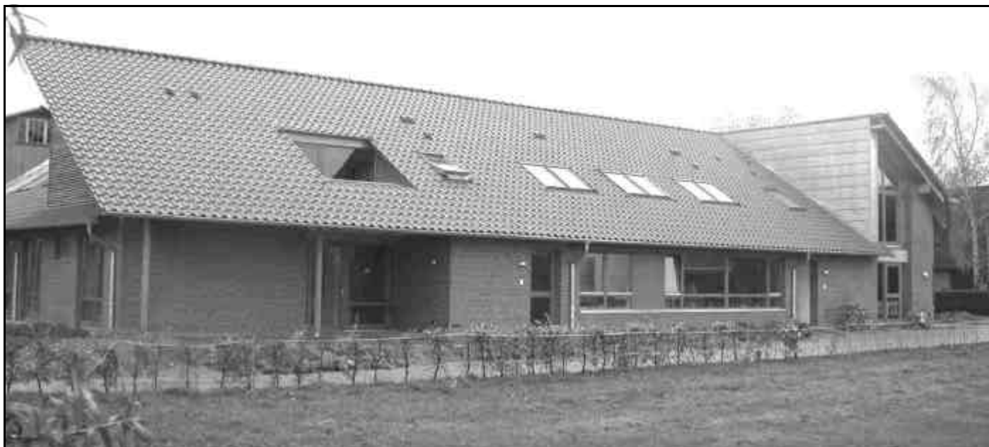
Ziegelstein, Holz, Zink - das neue Haus zweimal vom Feld her gesehen (oben und unten)
